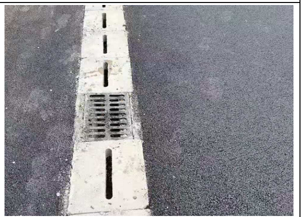
位置：教育配套工程 现场：道路一侧布置雨水管网
