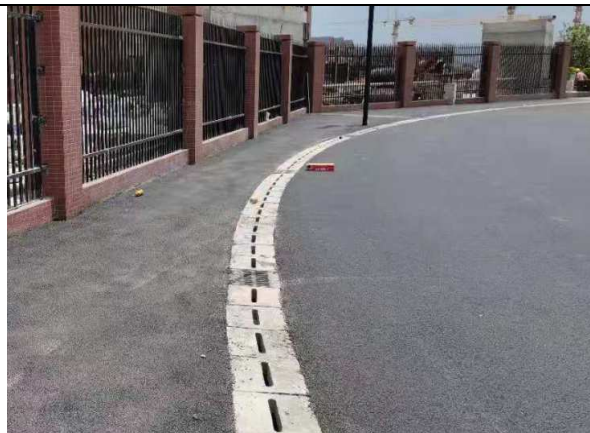
位置：教育配套工程 现场：道路一侧布置雨水管网
