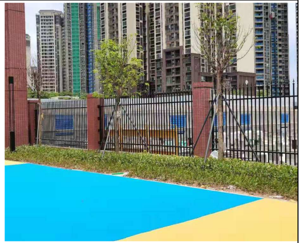
位置：教育配套工程 现场：可绿化区完成园林绿化工程，植被恢复较好
